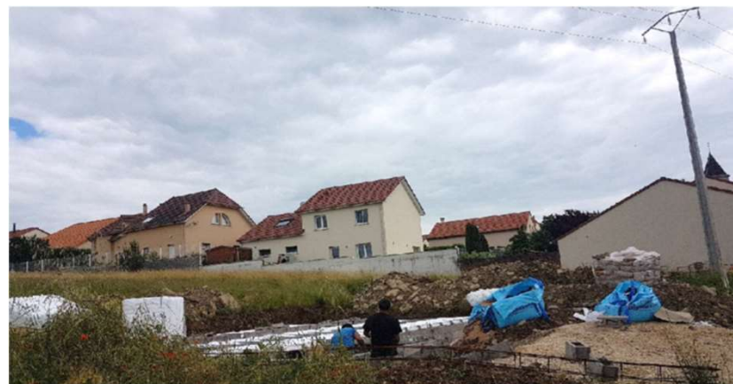
Chantier de construction du pavillon
