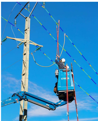
Opération TST de dépose des ponts gainés
