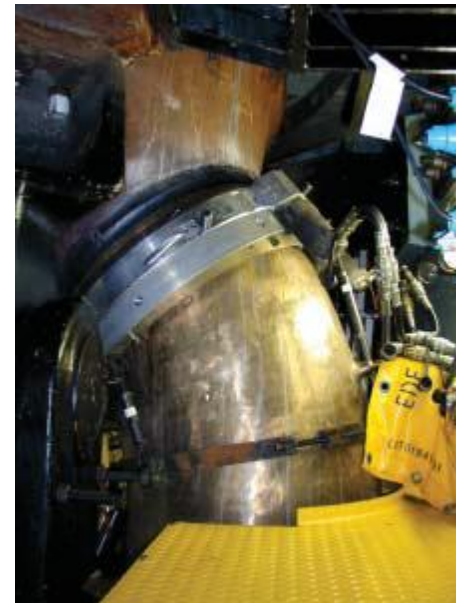
Découpe de tuyauterie primaire sous générateur de vapeur avec la machine Sumo (photo SFEN – RGN N°5 -11/2004)
