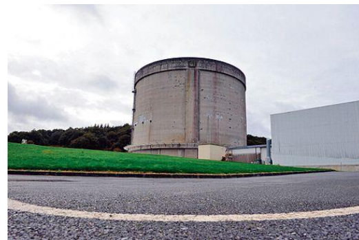
Centrale de Brennilis
