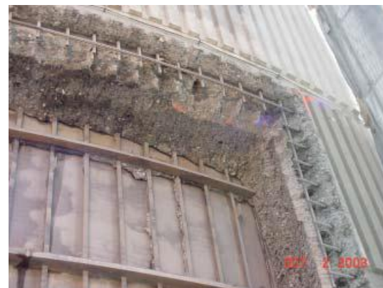
Découpe de l'enceinte extérieure en béton d'un réacteur. RGN N° 5 – 11/2004
